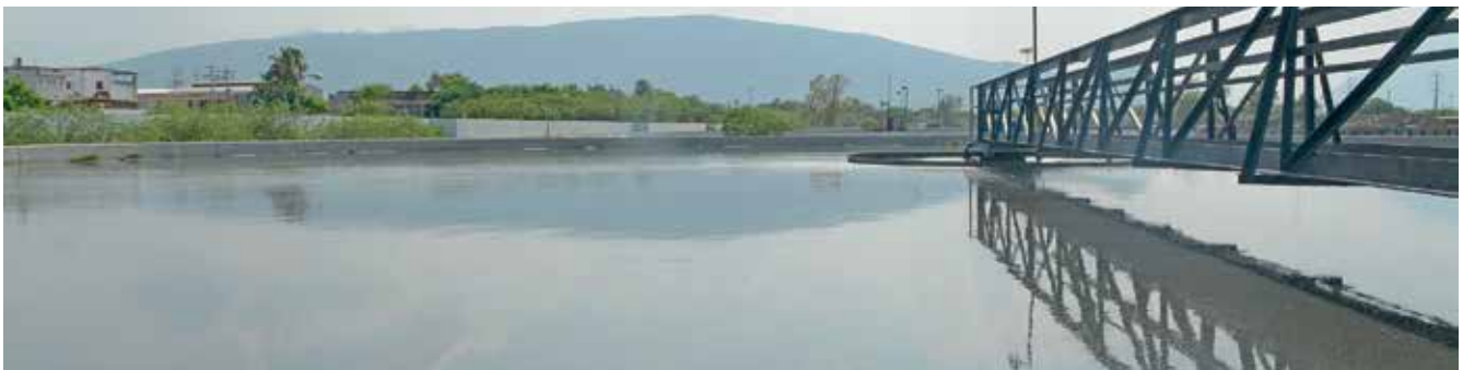
Planta de tratamiento de aguas residuales “Norte” en Monterrey, Nuevo León. Mayo, 2016.
