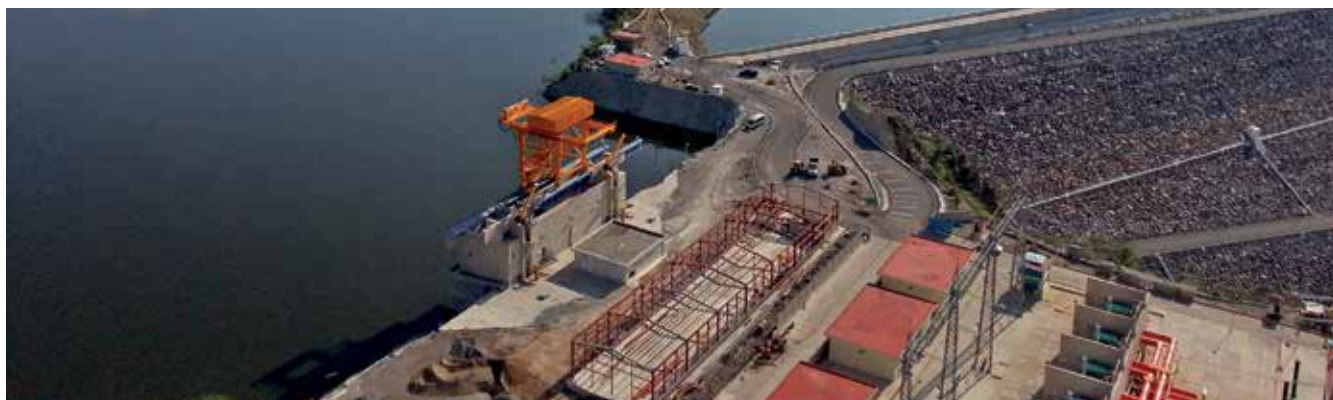
Vista aérea de la presa La Yesca, ubicada en el cauce del Río Grande de Santiago en el municipio de La Yesca, Nayarit y Hostotpaquillo, Jalisco.
