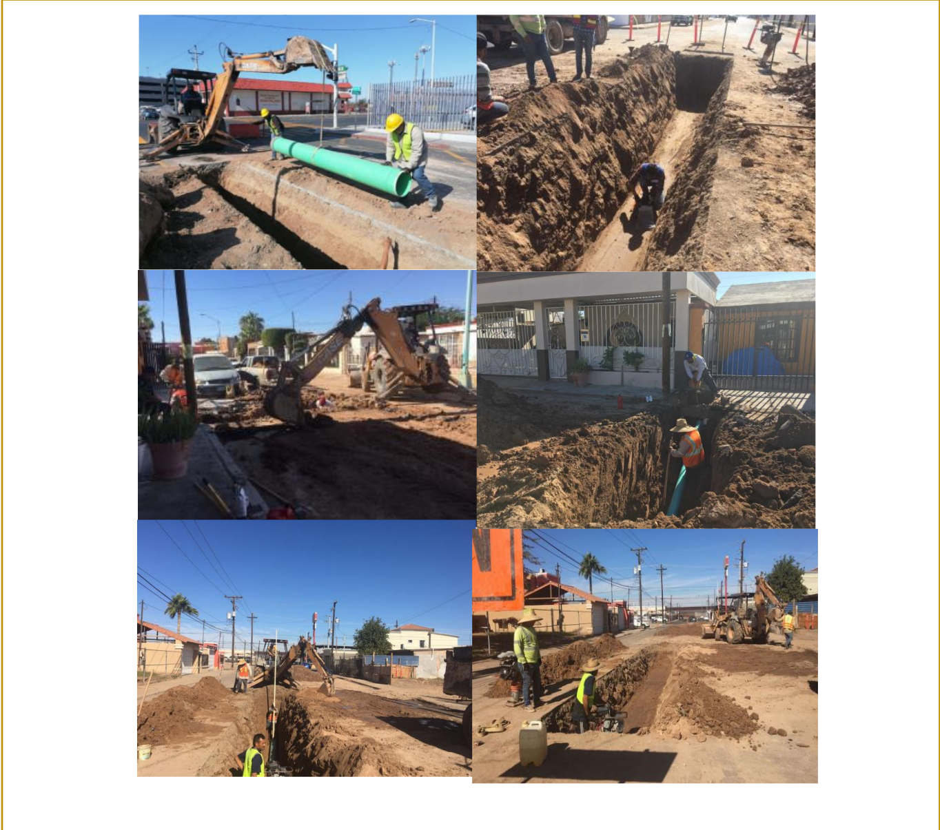
Figura 50. Fotografías de la obra
