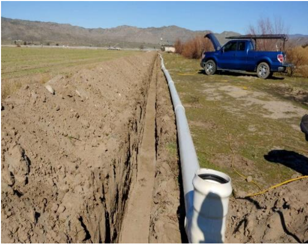
Suministro de tubería hidráulica de PVC
