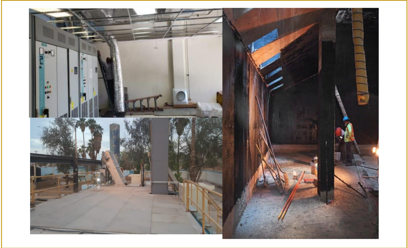
Figura 51. Fotografías de la obra
