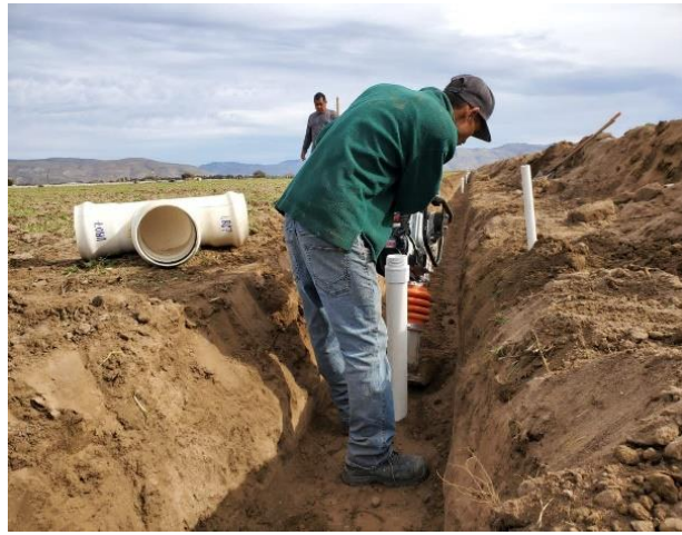
Trabajos de compactación con bailarina hidráulica
