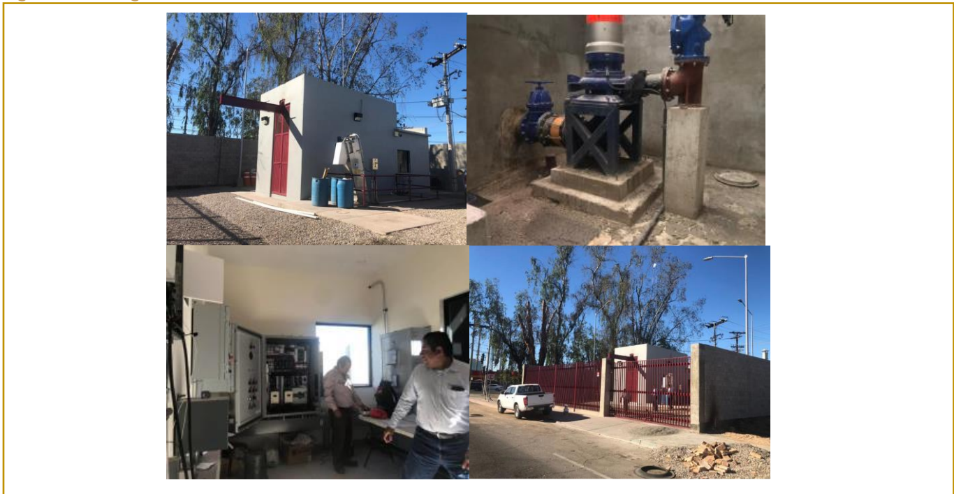
Figura 52. Fotografías de la obra
