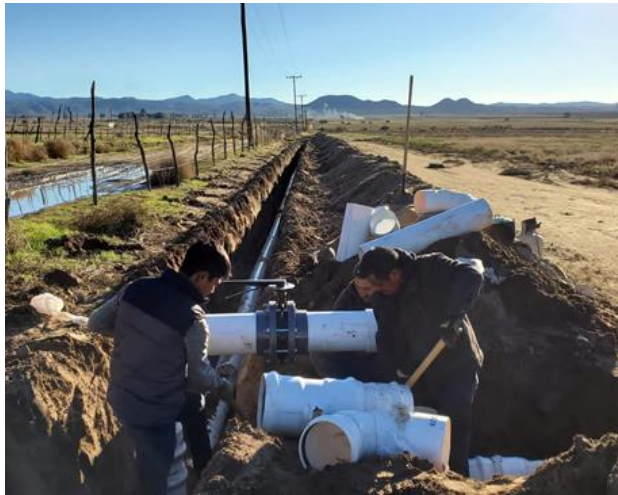
Proceso de suministro y colocación de válvula de mariposa
