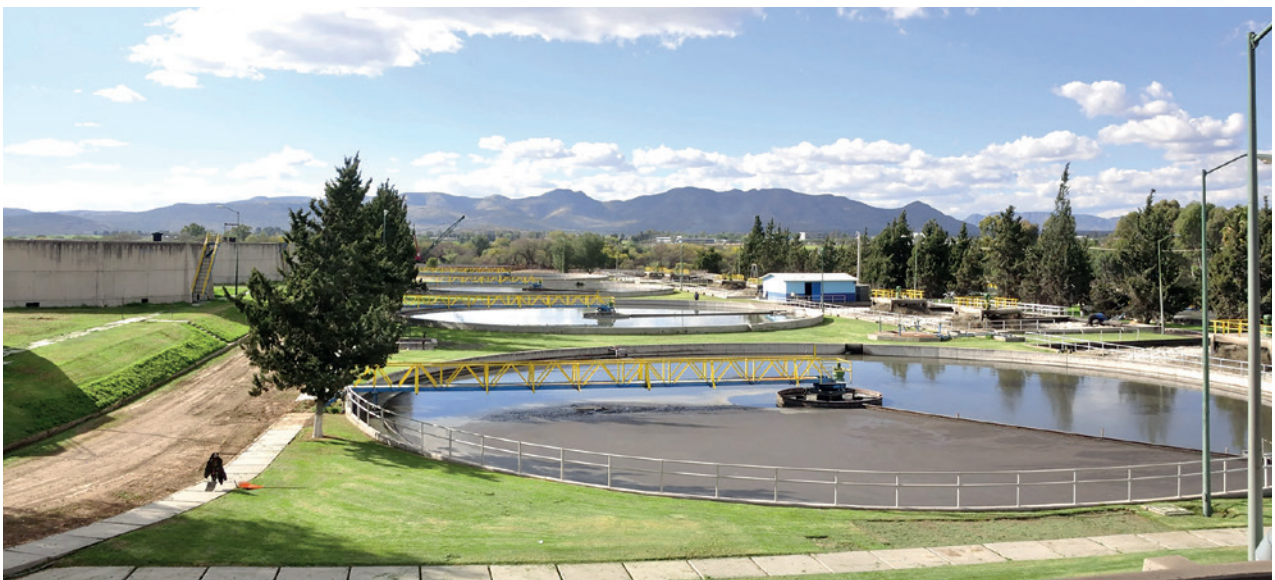
Instituto del Agua del Estado, PTAR, Aguascalientes.
