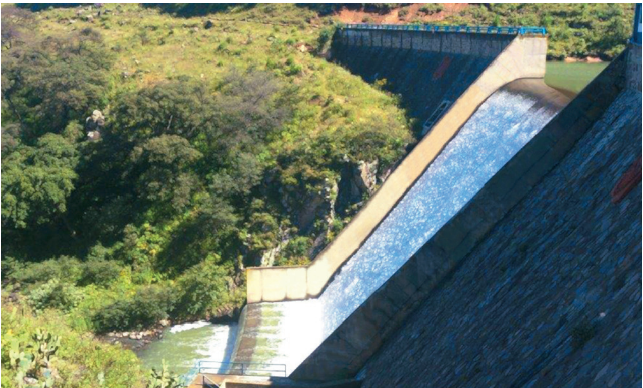
Vertedor de la Presa Tepetitlan, San Felipe del Progreso.
