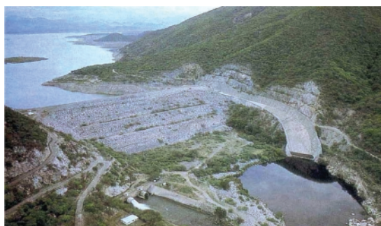
Sistema de Almacenamiento
